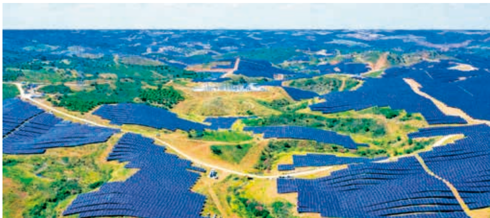
承建欧洲单体装机容量最大的光伏电站
